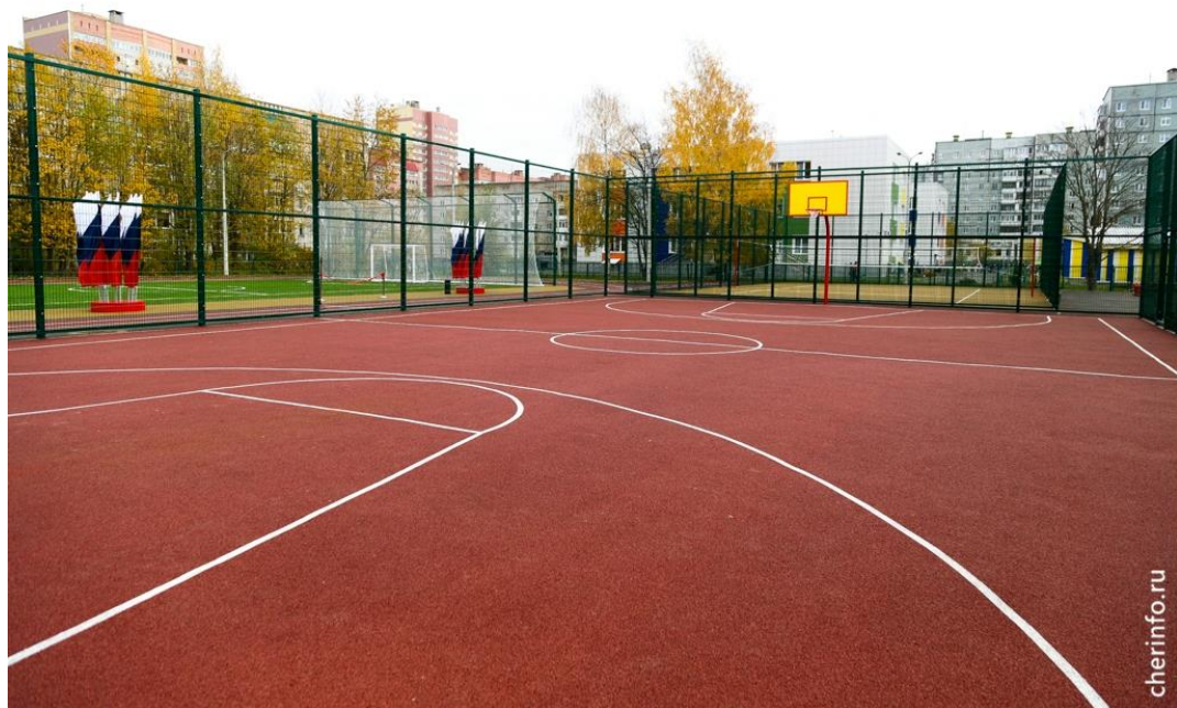
Обустройство пришкольного стадиона на территории МАОУ «СОШ № 28».
