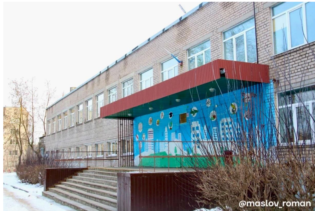
Капитальный ремонт МАОУ «СОШ №27».
