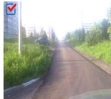
Подсыпка обочины, ремонт полотна дороги к домам ул. К. Белова, 46, 46А, 46Б
