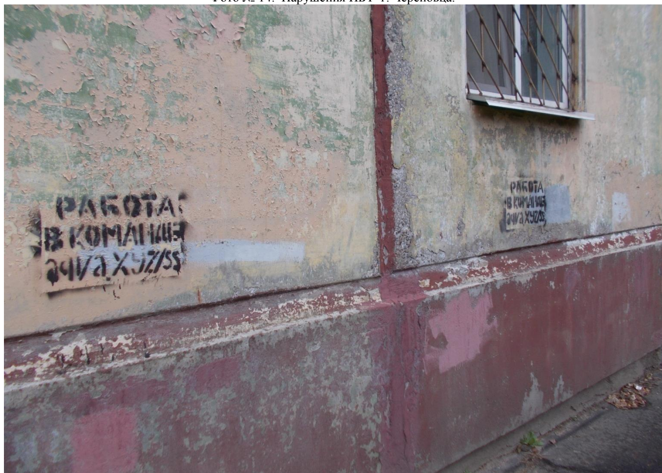
Фото № 15. Нарушения ПБТ г. Череповца.
