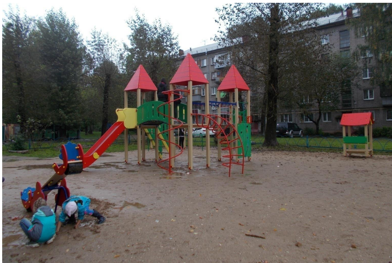
Фото № 19. Обустройство новой детской площадки на ул. Ломоносова, дом 10.
