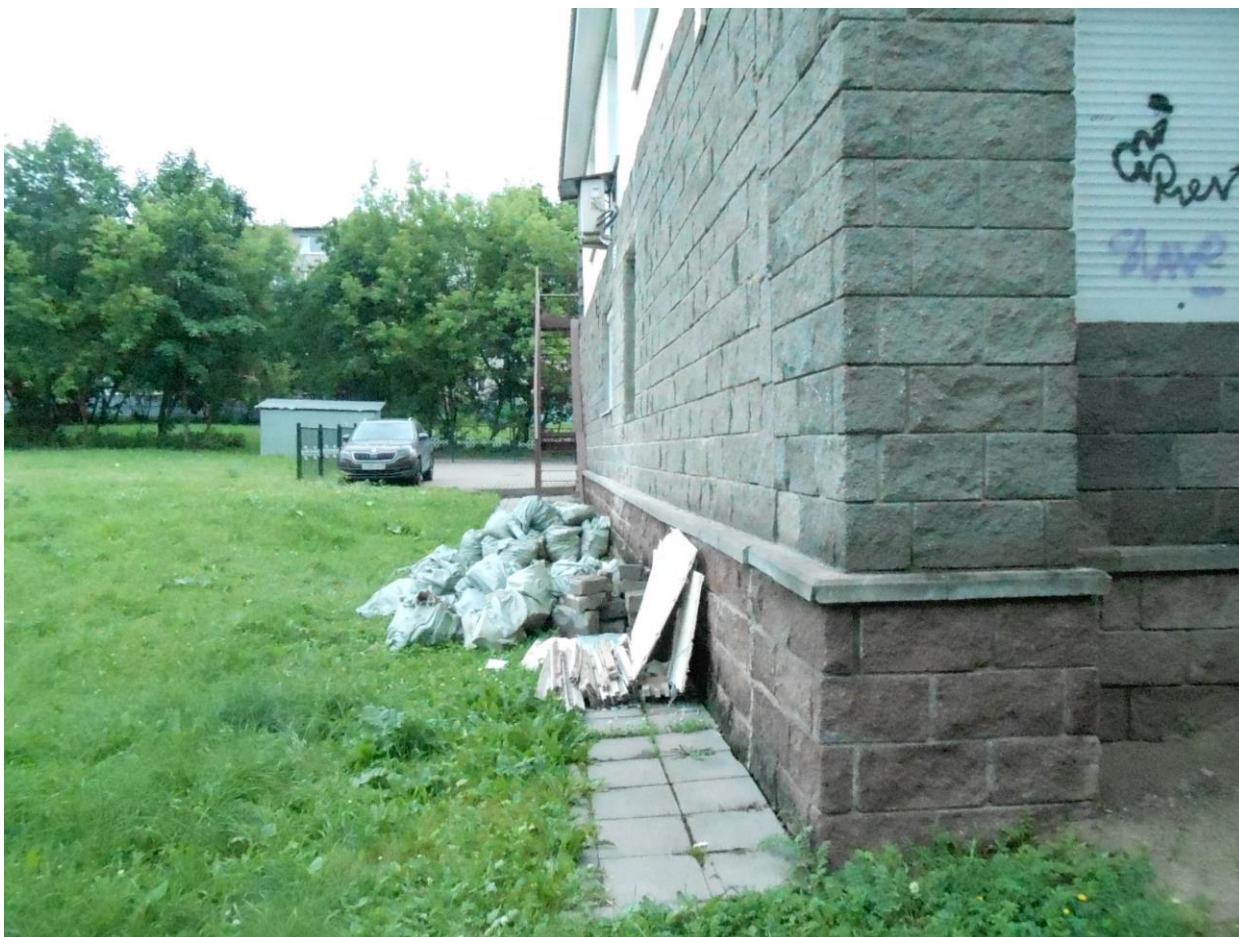
Фото № 11. нарушение, решенное в рабочем порядке (строительный мусор у д.72 а по Краснодонцев)
