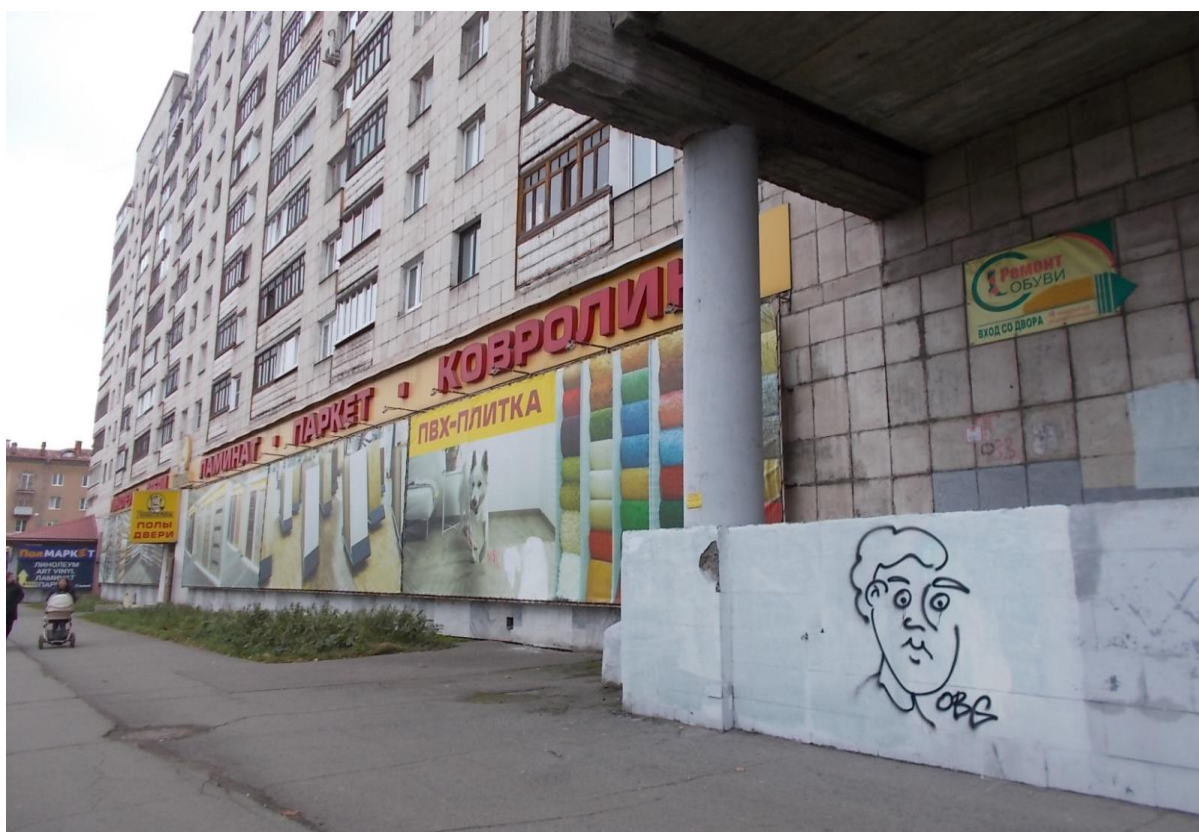
Фотография № 17 Наличие несанкционированных надписей на фасаде дома: ул. Сталеваров, 46
