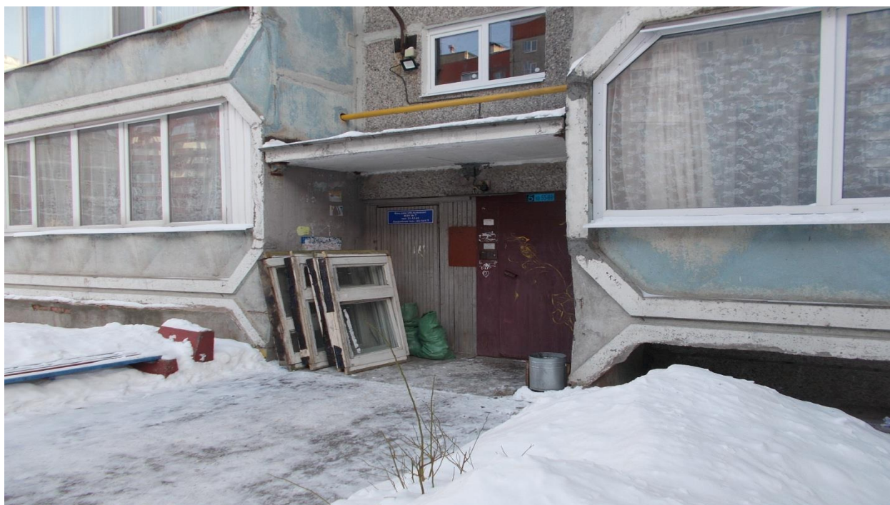
Фотография № 11. Складирование КГМ вне контейнерной площадки.
