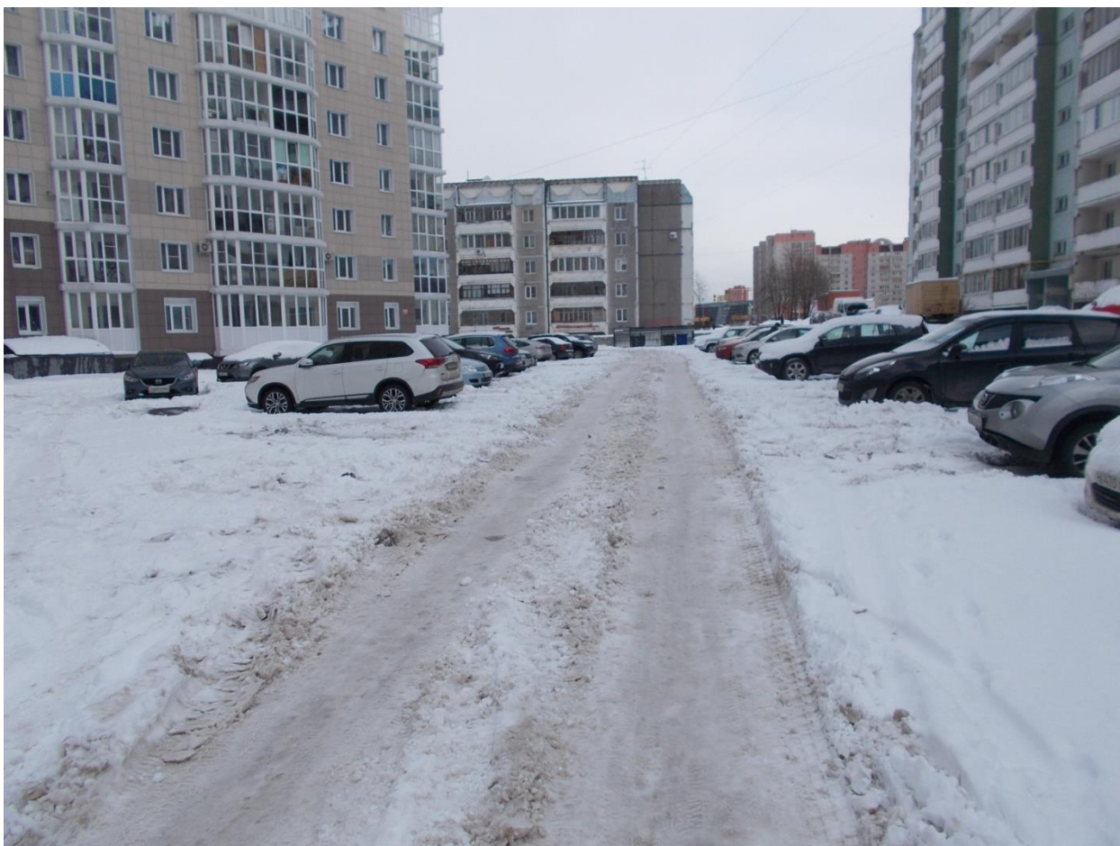
Фотография № 5. Несвоевременная уборка снега с проезжей части, ул. Наседкина, д.19
