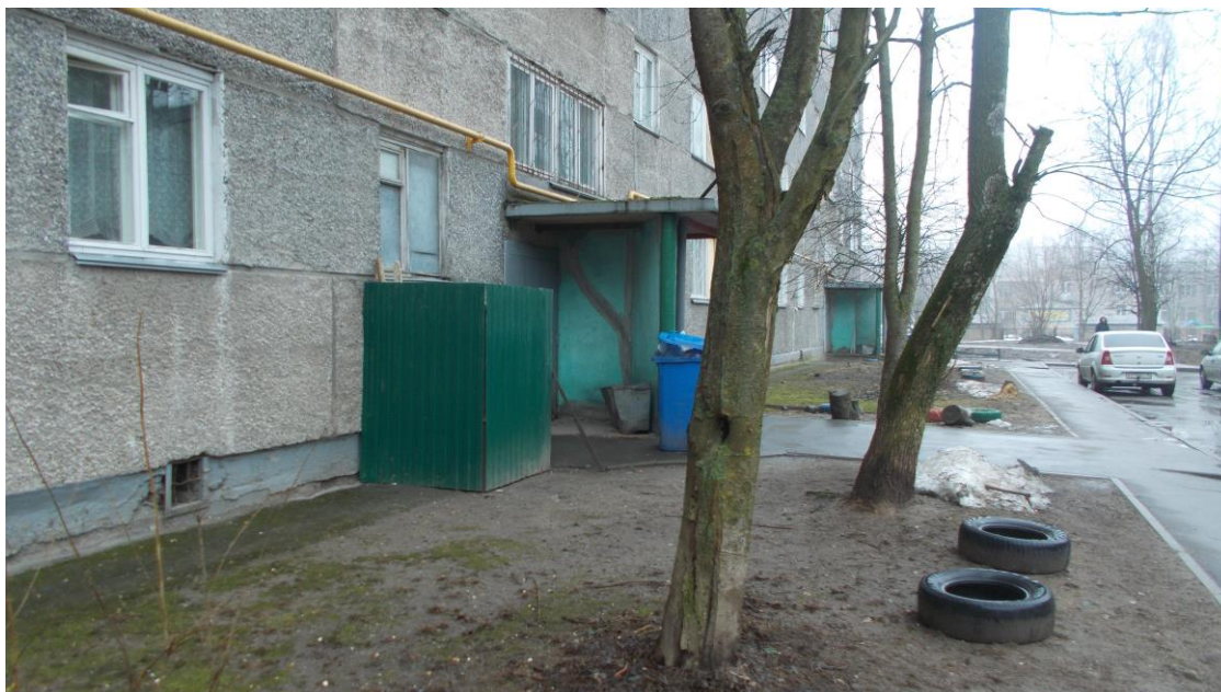
Фото № 6. Оборудованная контейнерная площадка пр.Победы,182
