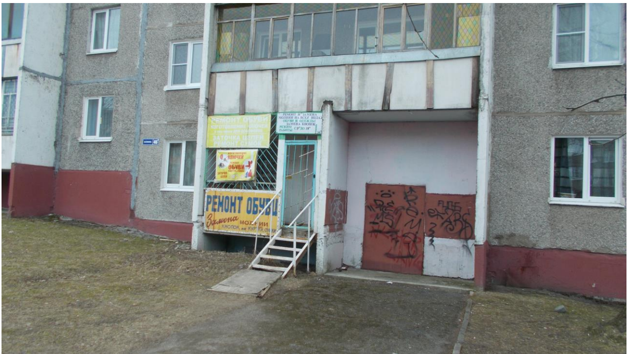
Фото № 9. Самовольно произведенные надписи на фасаде здания д. 46 «а» по ул. К. Беяева
