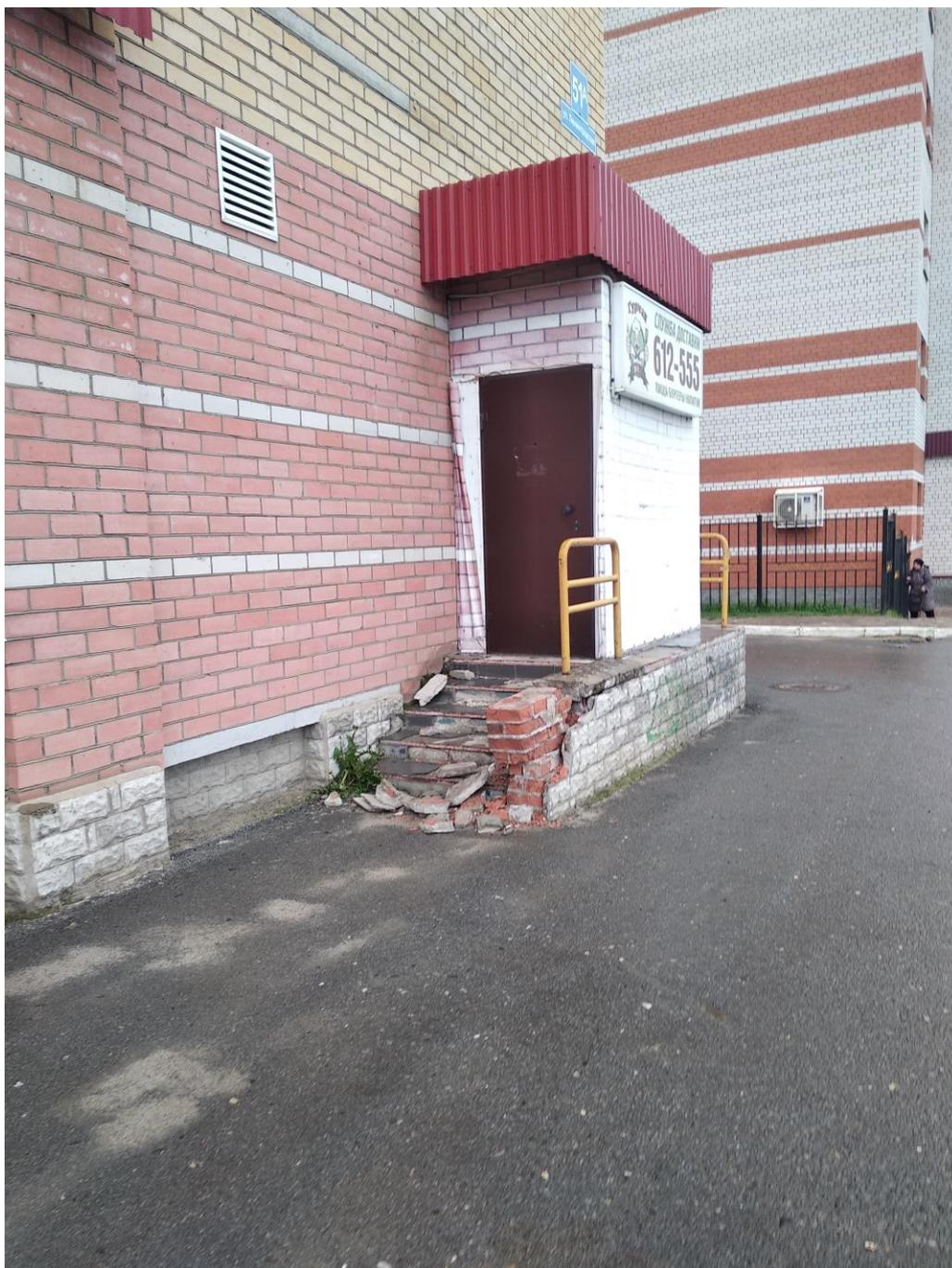
фото №12 повреждение кирпичной кладки крыльца
