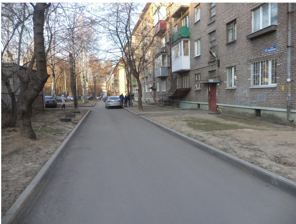
Фотография № 25 ул. Ломоносова, д.51 ( после ремонта дворовой территории).
