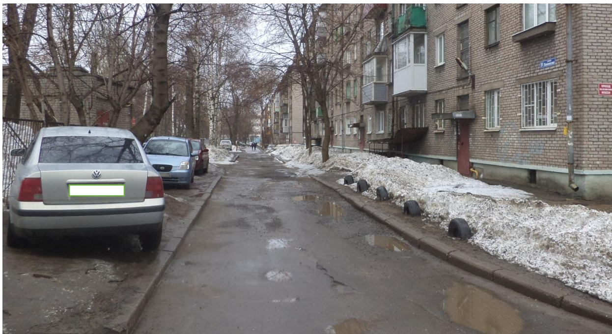
Фотография № 24. ул. Ломоносова, д.51 (до ремонта дворовой территории)
