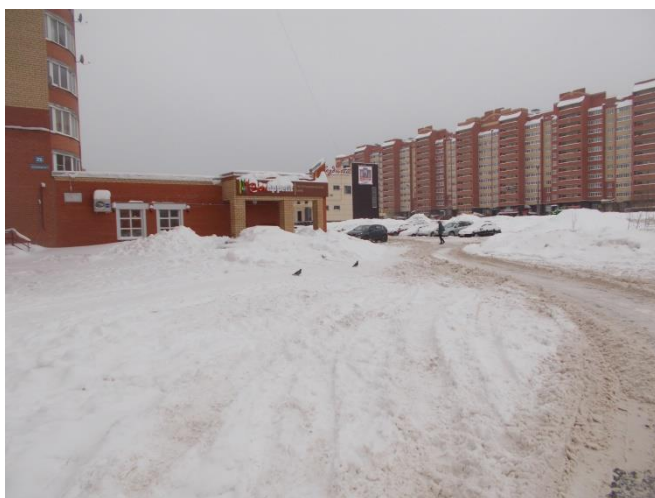
Проезжая часть дороги у дома №25 Шекснинскому проспекту
