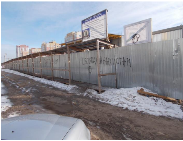
Улица Ленинградская (ограждение строящегося здания суда)
