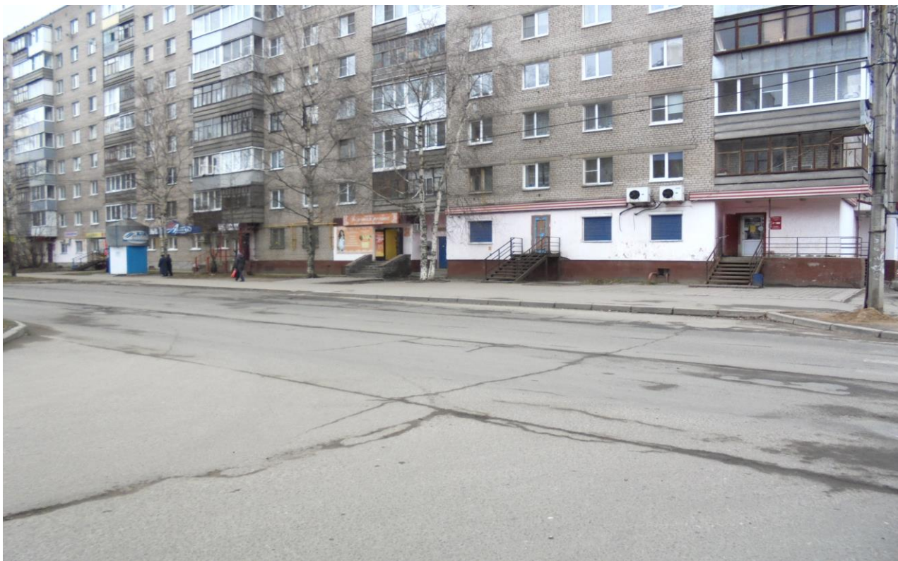
Фото 20. Автобусная остановка д. 33 по ул. Гоголя.
