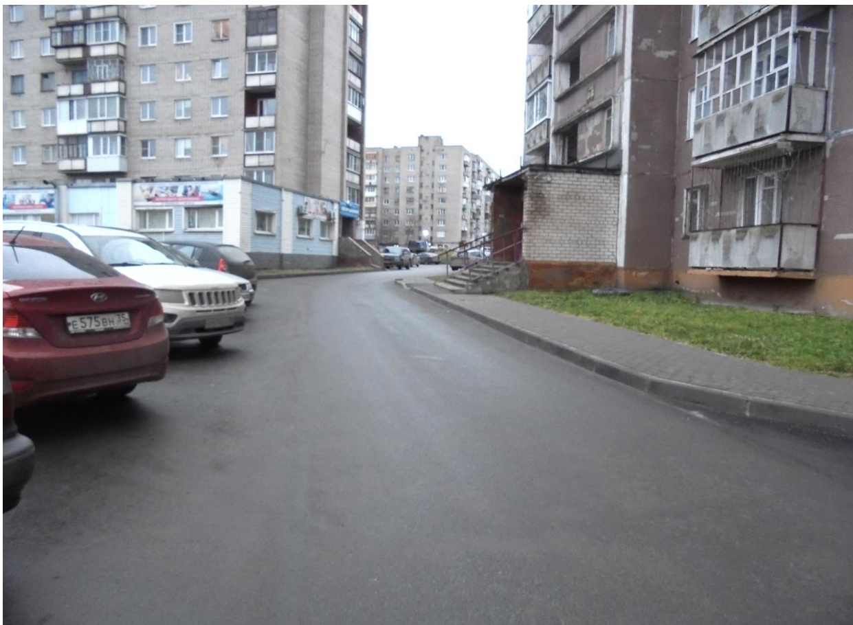
Фото 12. Дворовая территория у дома № 26/ А по ул. Химиков (после ремонта)
