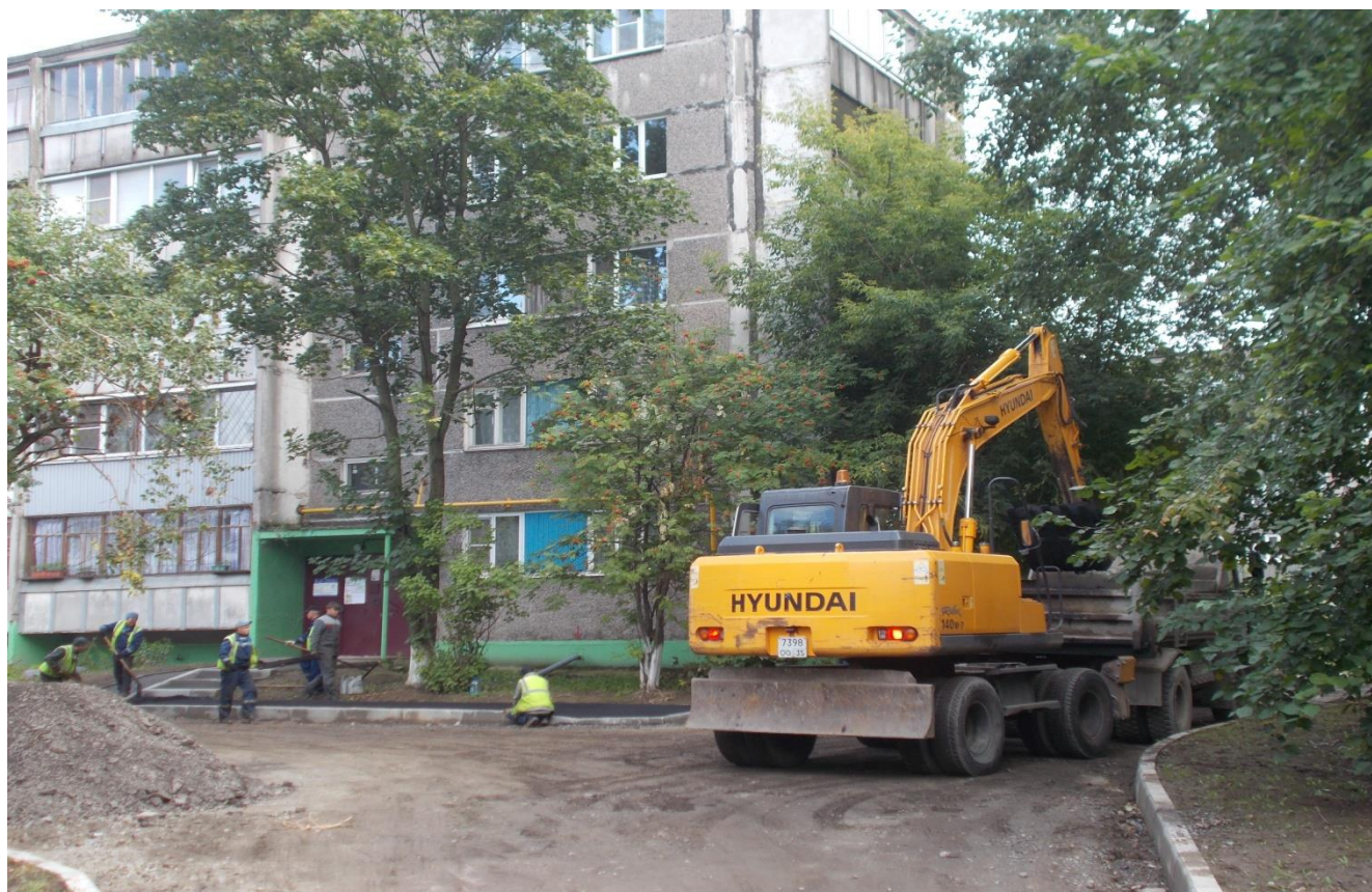
Ремонт двора Северное шоссе, 17
