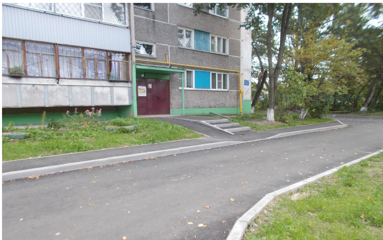
Тот же двор после ремонта
