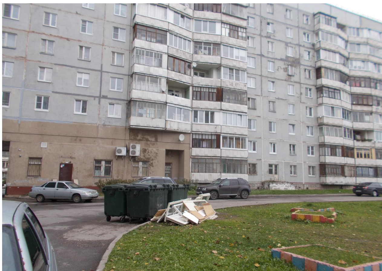
Фото № 9. Захламление газона строительным мусором.
