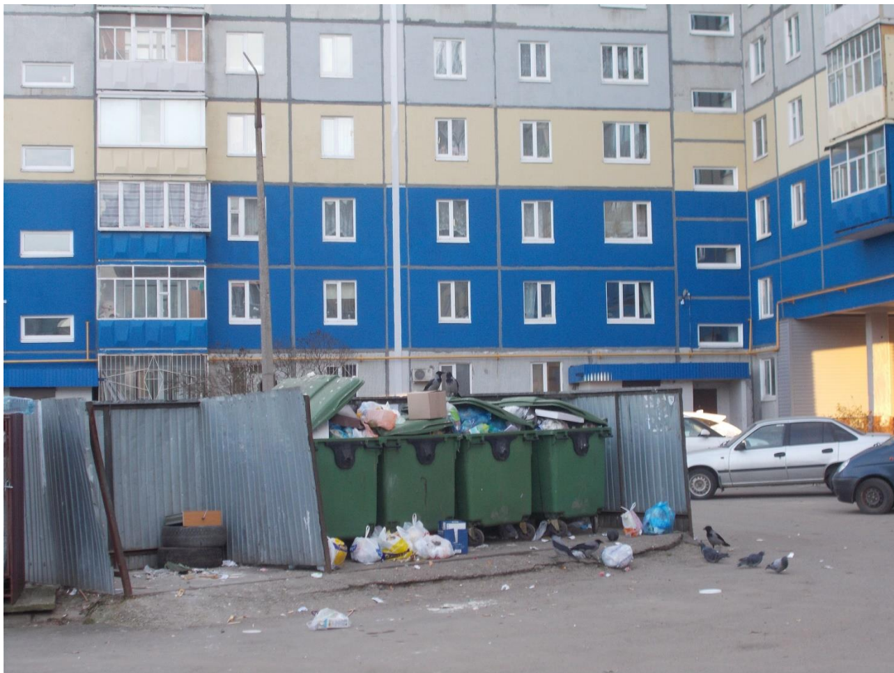
Фото № 6 Переполнение контейнеров с бытовым мусором.
