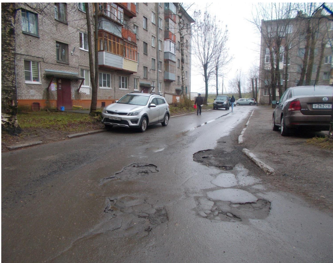
Фото № 18. Проезжая часть у дома 118 по ул. Архангельская через месяц после ремонта.
