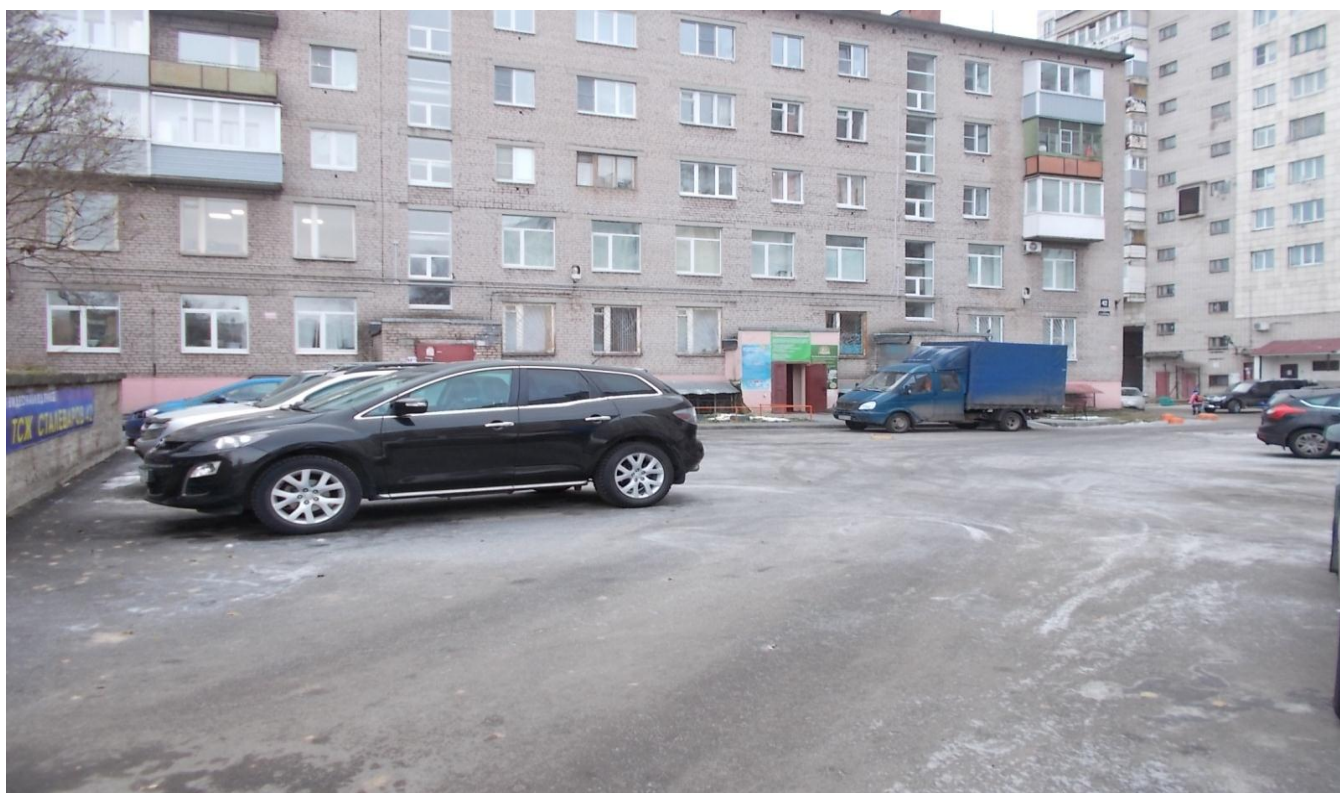
Фото 15. Ремонт дворовых дорожных покрытий, тротуаров с расширением парковочной зоны по ул. Сталеваров, 42.
