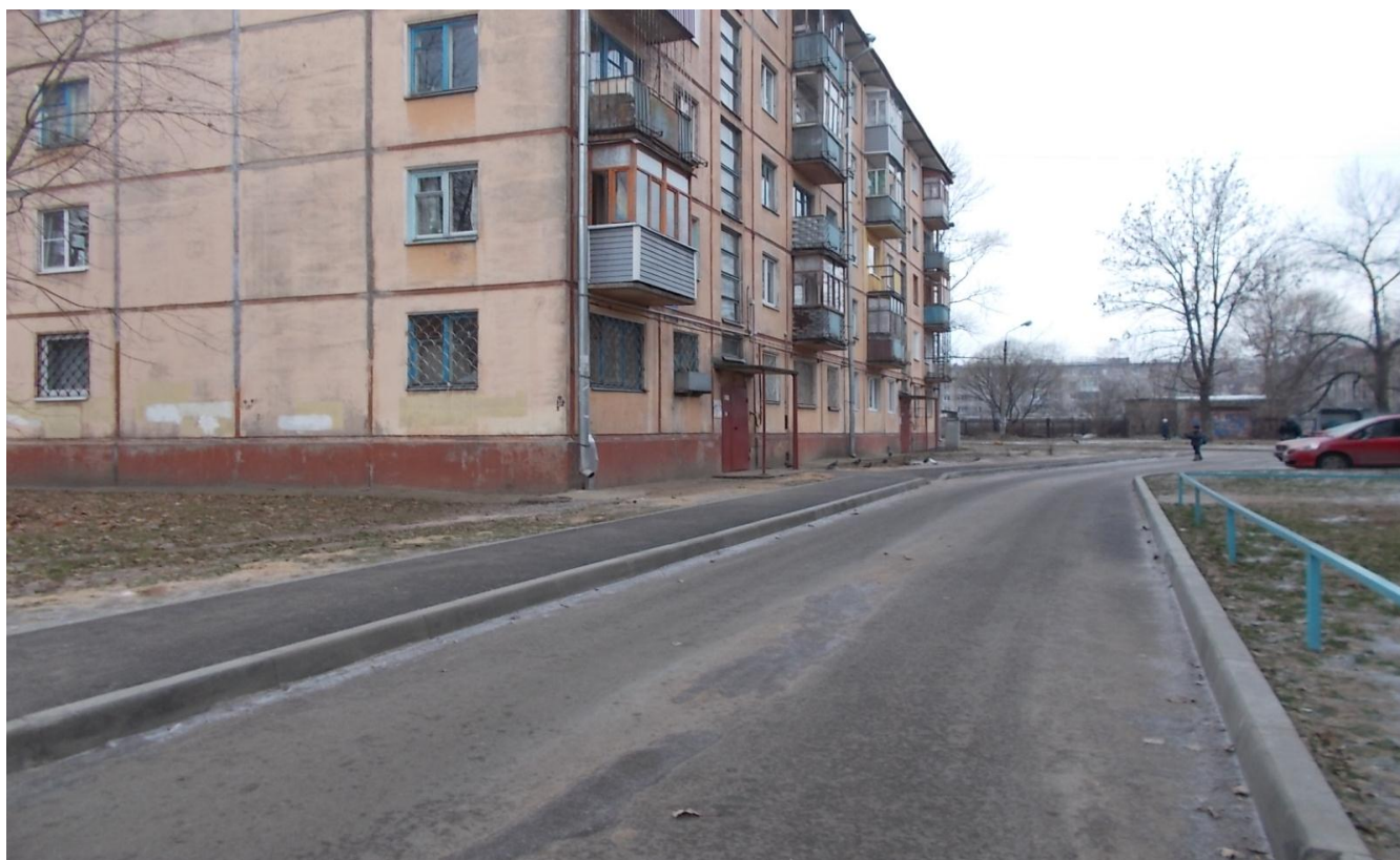
Фото 16. Ремонт дворовых дорожных покрытий, тротуаров с расширением парковочной зоны по ул. ул. Ленина, 107
