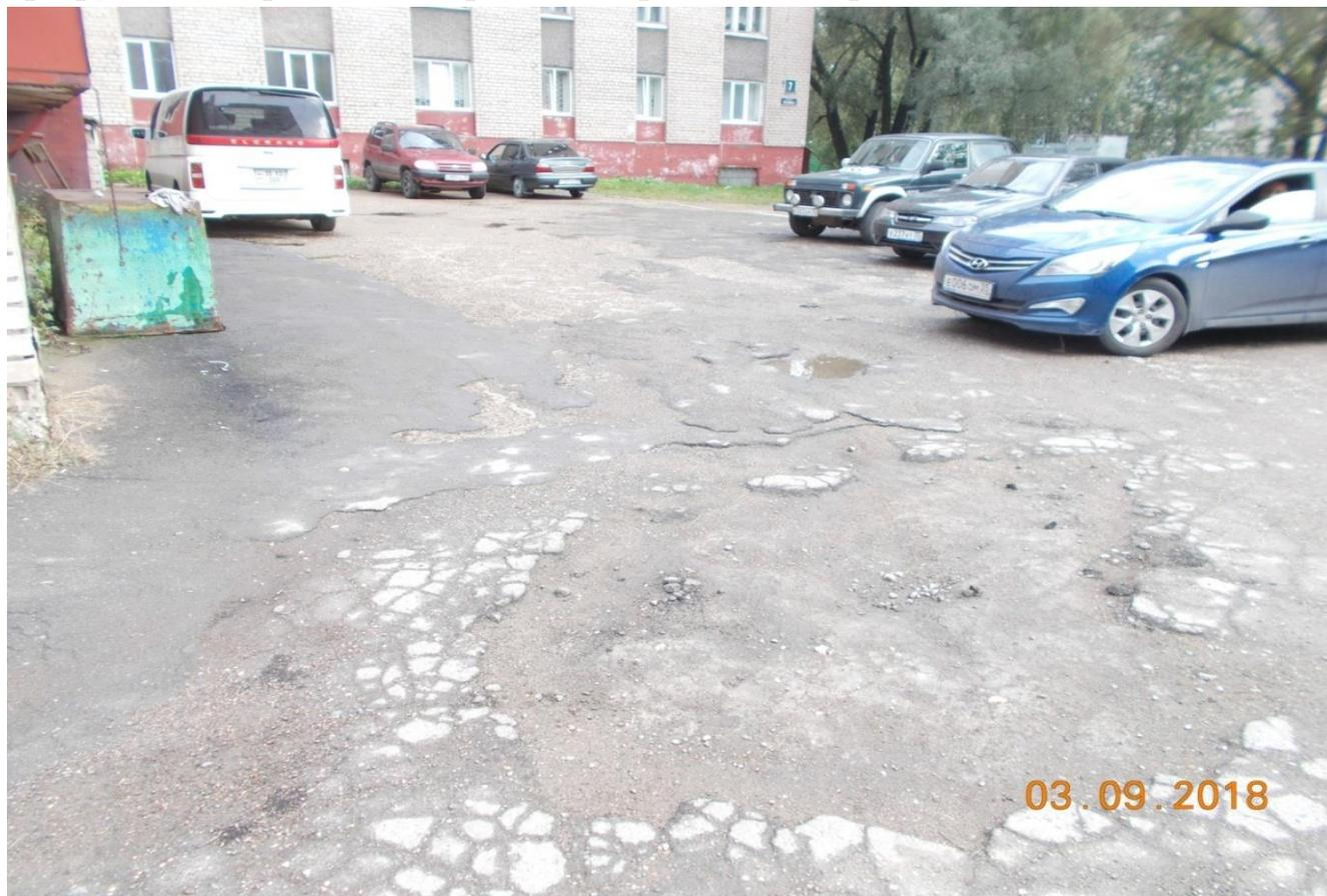
Фото № 13. Разрушение дорожного покрытия на придомовых проездах
