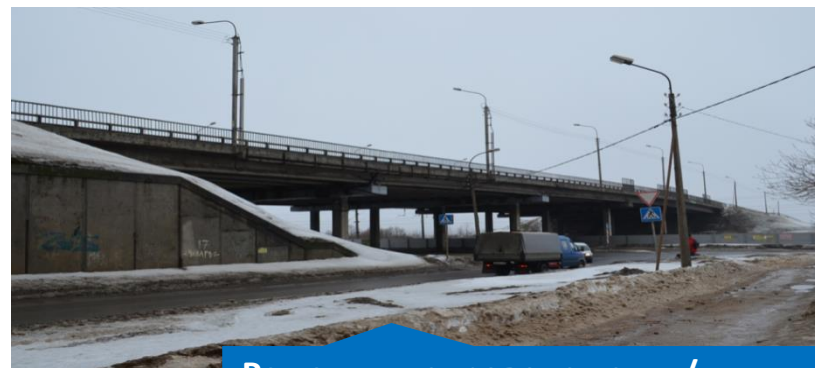
Ремонт путепровода над ж/д по ул. Архангельской
