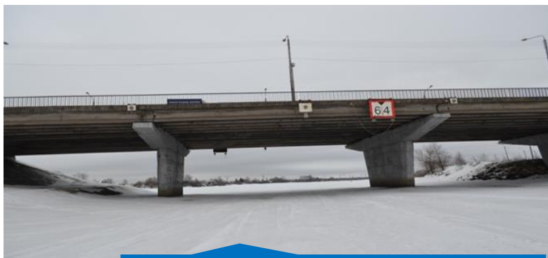
Ремонт Северного моста
