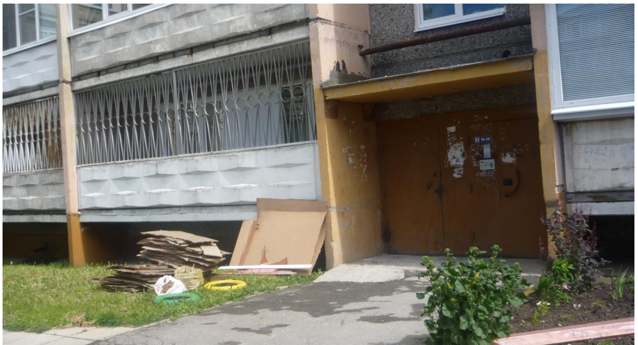
Фото № 4. Складирование мусора у подъезда.
