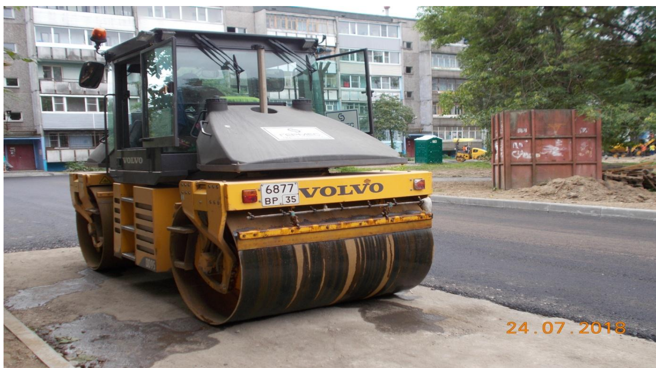
Ремонт дворов Ветеранов, 24 и Ветеранов, 26
