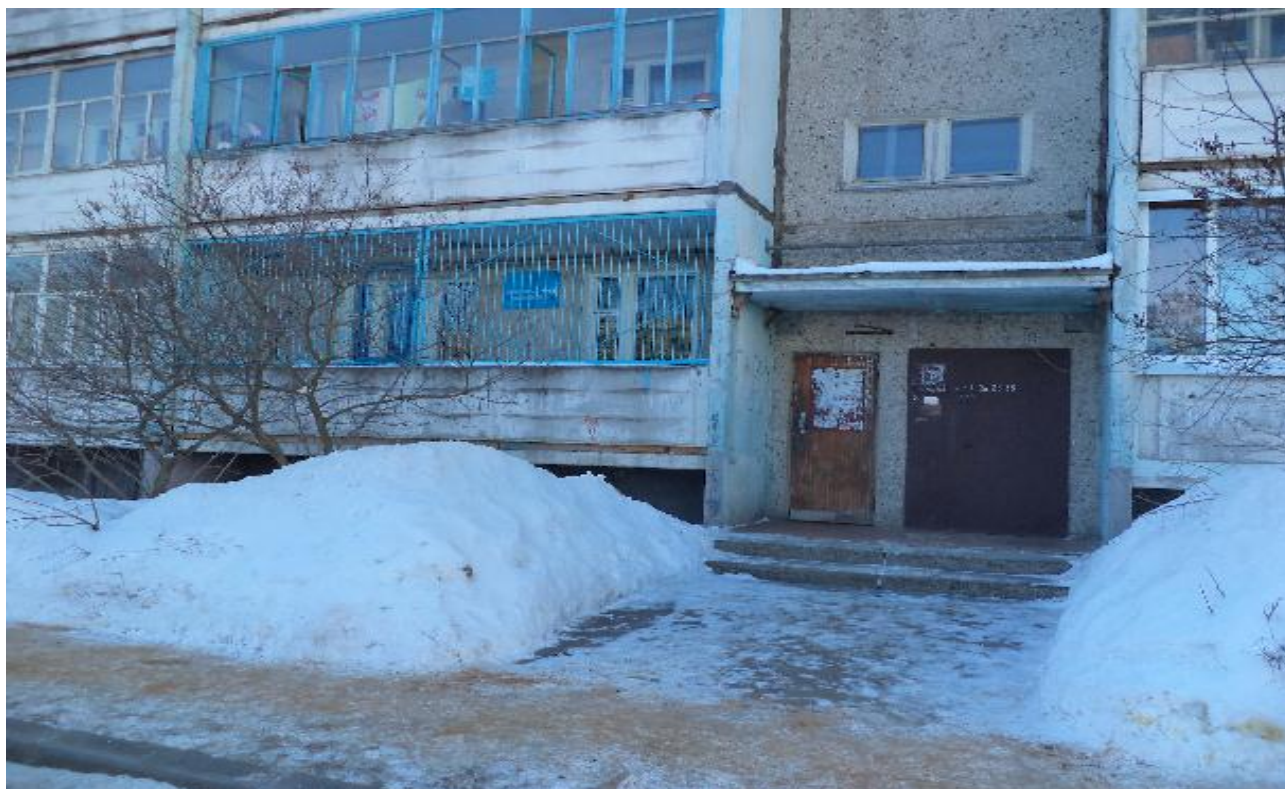
Фото № 1. Филиал центра профилактики правонарушений 104 и 114 икр.
