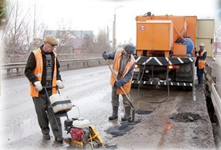
содержание и ремонт улично-дорожной сети
