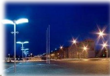
обеспечение работы линий освещения общегородских территорий
