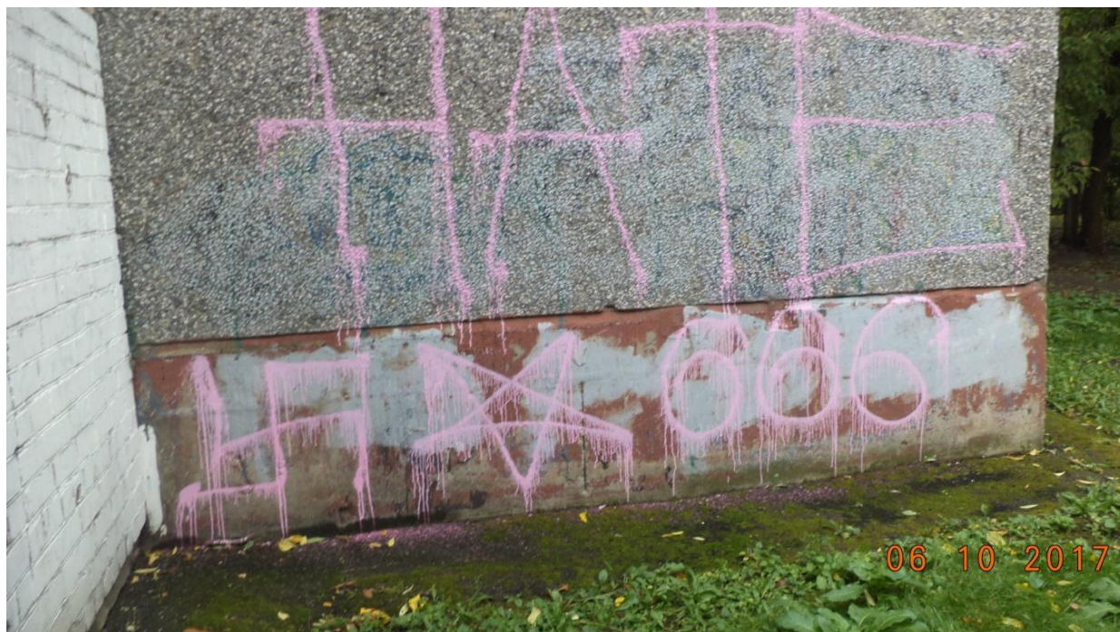
Фото №10: Надписи на фасаде многоквартирного жилого дома.
