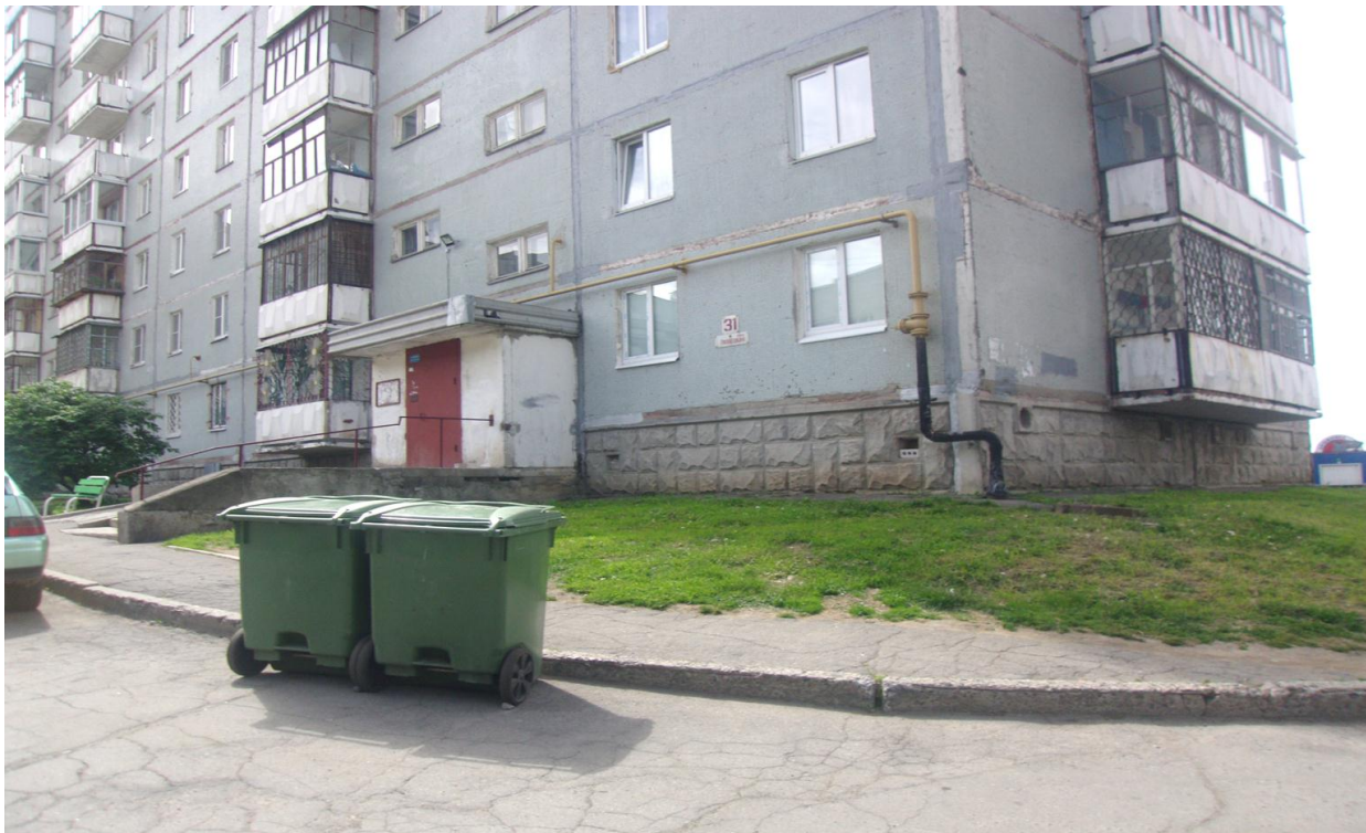
Фотография № 13. Контейнеры на проезжей части у дома № 31 по ул. Любецкой.
