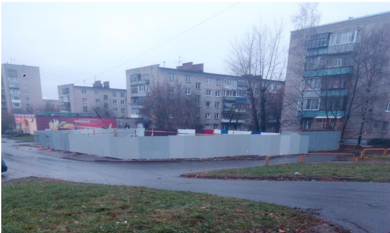
Фото № 15. Старая палатка снесена, территория убрана и ведется строительство.
