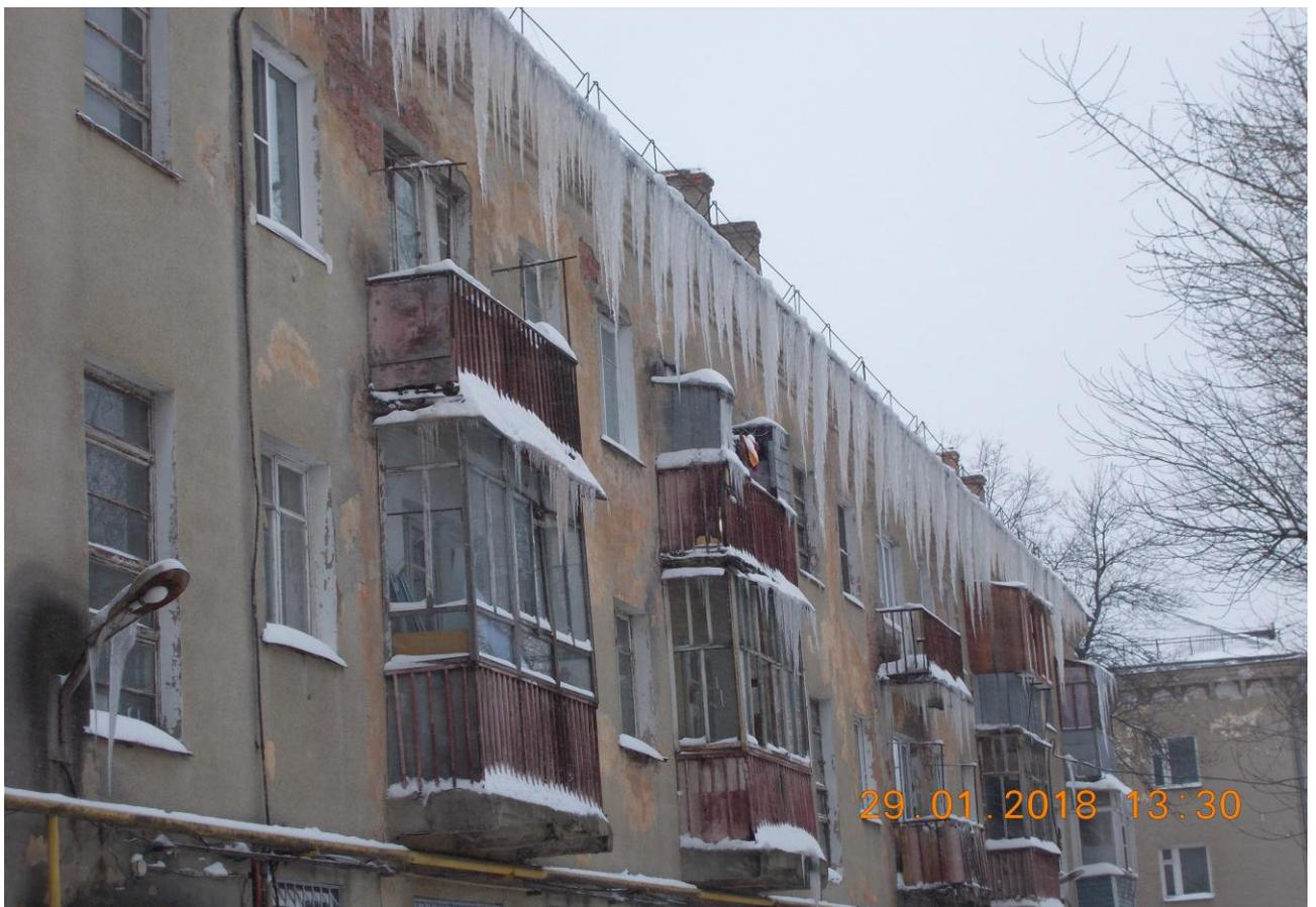
Фото № 13. Снежно-ледяные образования на свесах кровли.
