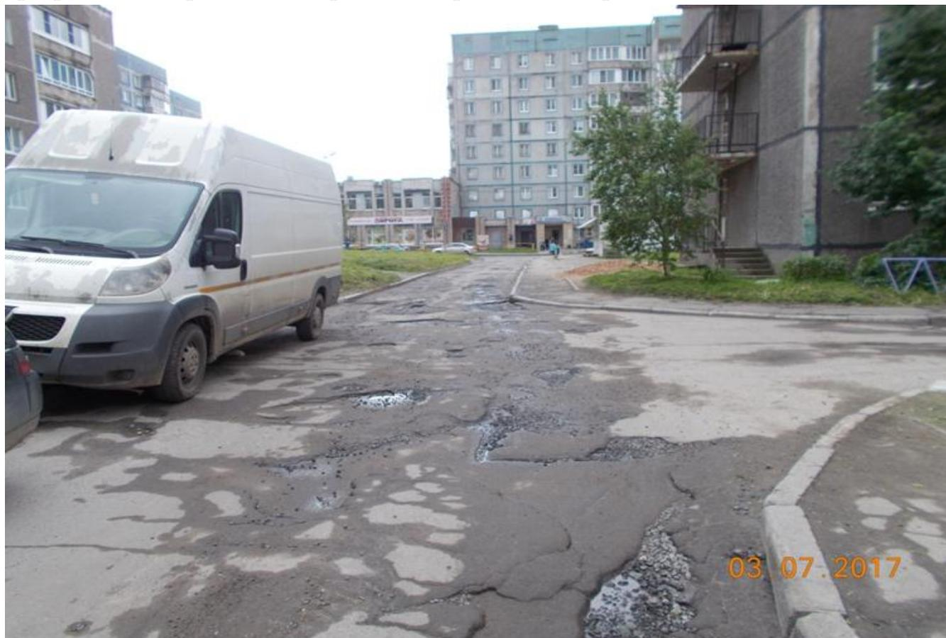
Фото № 14. Разрушение дорожного покрытия на придомовых проездах
