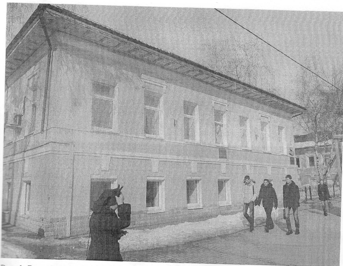
Рис. 1. Вид на объект со стороны Советского проспекта.
