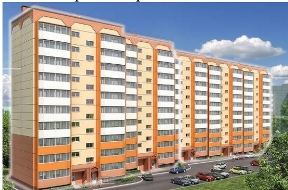
Жилой дом №2 в 20 мкр. (I, II очередь), ул. Гоголя, 16
