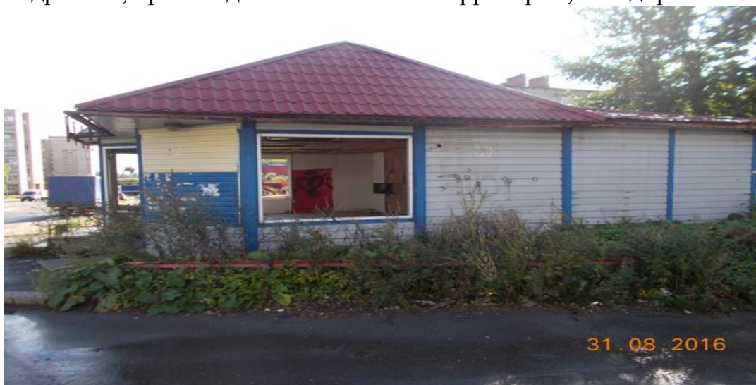
Фото № 11. Наличие заброшенного павильона у д.1 на ул. Ветеранов.
