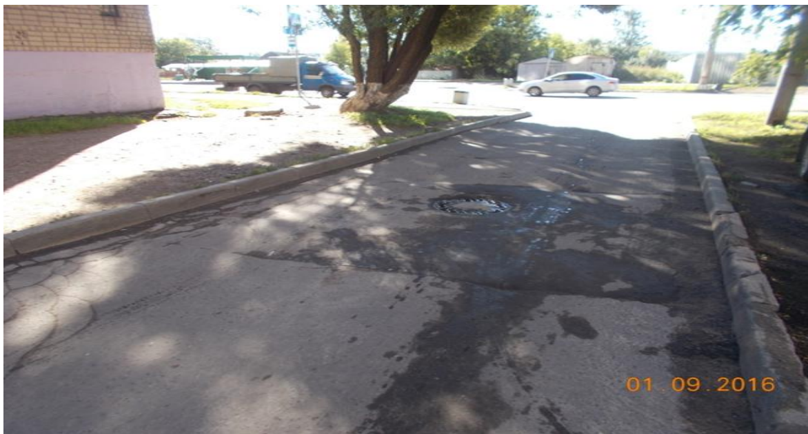
Фото № 15. Ремонт дороги на придомовой территории.
