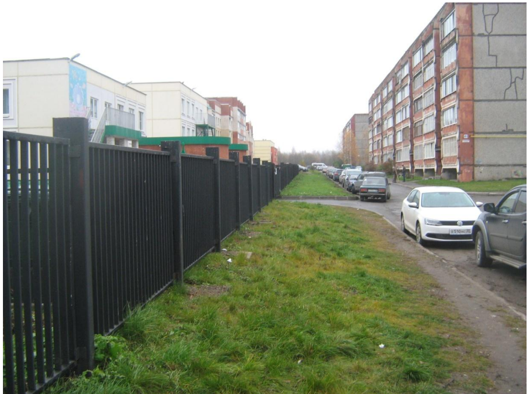
Фотография №2. Восстановленная санитарная зона и зелёный покров газона.
