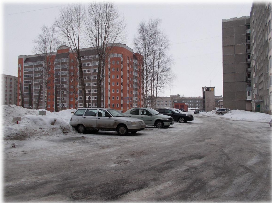
Благоустройство парковочных мест на придомовой территории
