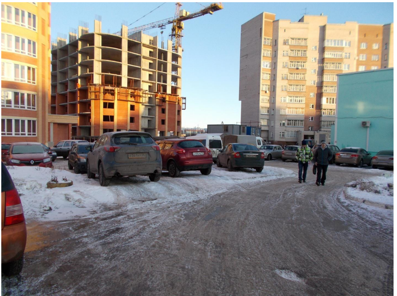
Фотография № 3. Незаконная парковка автомобилей на газоне пр. Октябрьский, 43.
