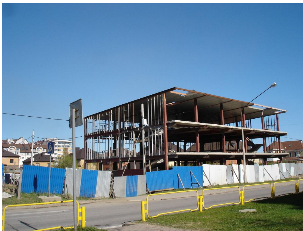
ФОТО № 11: «Замороженный» строительный объект (рядом с домом ул. Батюшкова, 5)
