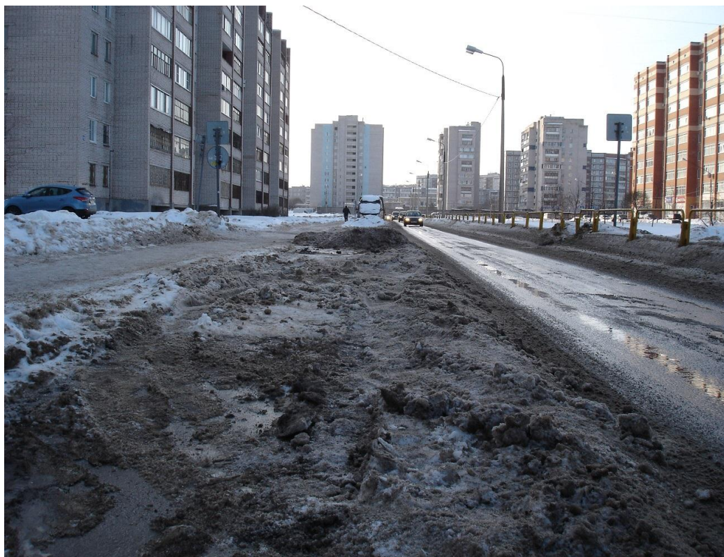
ФОТО № 2: проезжая часть дороги на всю ширину не очищена от снежно-ледяных образований
